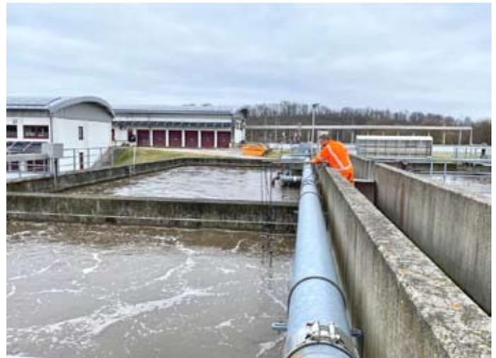
Bild 2: Trotz Mikroorganismen ist rund um die Belebungsbecken viel energieintensivste Technik im Einsatz. (Bild: WAD GmbH)
