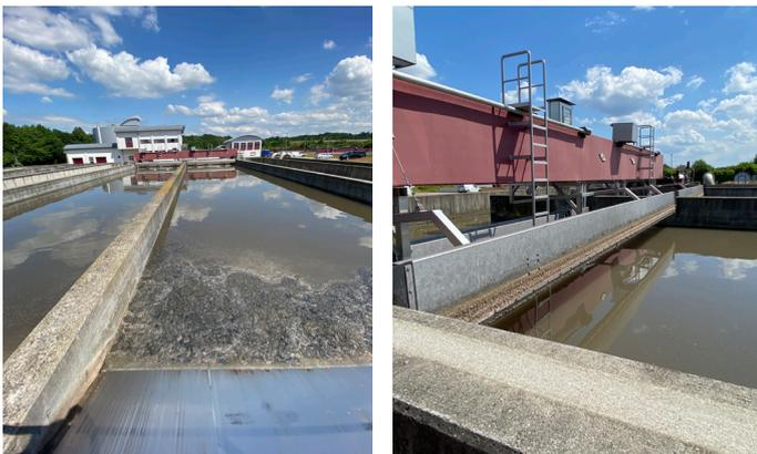
Bild 3 (links): Schwimmschlamm, der regelmäßig entfernt wird
