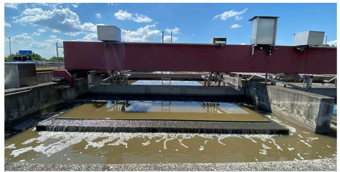
Bild 2: Längsbecken, von denen zwei ständig im Betrieb (Sommer- und Winterbecken) sind (Bild: WAD GmbH)
