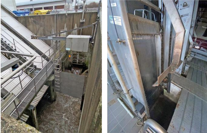
Bild 2 (links): Jede unserer Schnecken schafft es, 560 l/s anzuheben. Der Zulauf bei Trockenwetter beträgt durchschnittlich 17.000 Kubikmeter Abwasser/Tag. Bei Regenwetter verzeichnen wir einen Zulauf von bis zu 1200l/s. Dafür ist unsere Kläranlage auch bei Havariefällen ausgelegt, um eine stabile Abwasserbehandlung zu gewährleisten (Bild: WAD GmbH)
